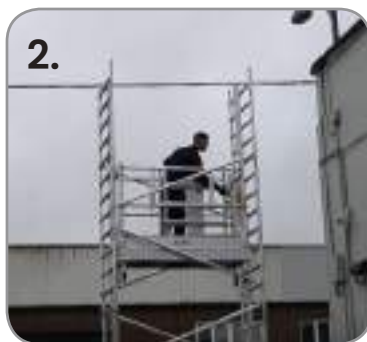
2. Elevar la plataforma a la altura necesaria
