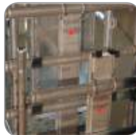
Sus marcos se cargan en el cesto portapersonas y se van ensamblando progresivamente
