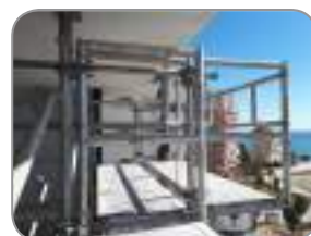
Las piezas de Tempo Balcón se pueden combinar con las piezas de Tempo para conformar un andamio Tempo de 4 m de altura
