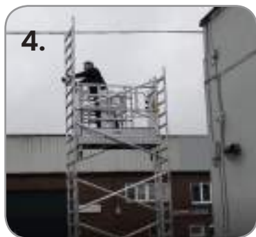
4. Colocar las abrazaderas
