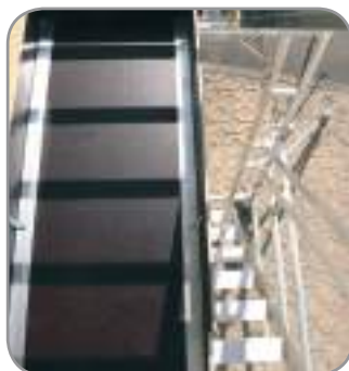
Plataforma intermedia con rodapiés en cada nivel
