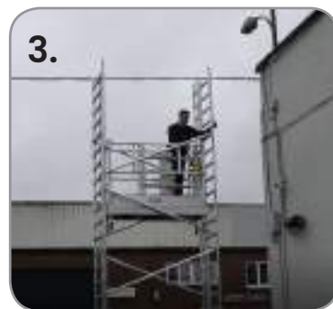
3. Ensamblar el marco lateral
