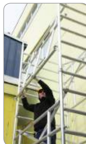
4. Barandillas equipadas con ganchos rápidos
